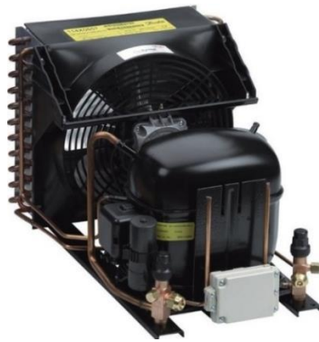
Fig. 4. 9 Condensing unit (Optyma™ Danfoss)
